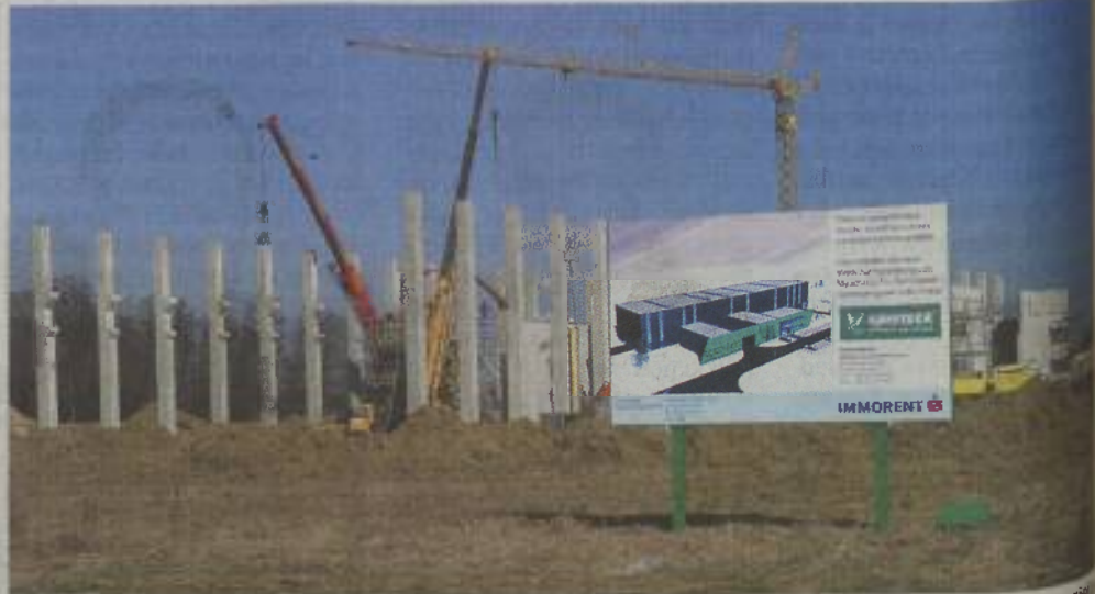
Gradnja nove tovarne Komptech v Ljutomeru poteka po načrtih. Proizvodnjo bodo zagnali predvidoma jeseni, v oktobru na začetku petdeset delovnih mest.
