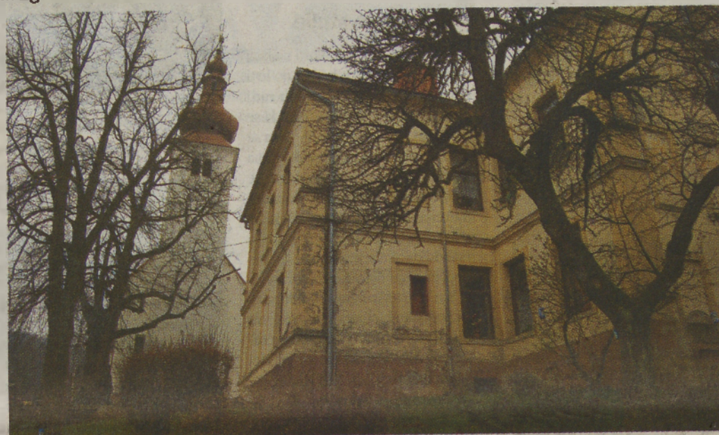
Stavba je iz leta 1900, za začetek šolstva v Cezanjevcih pa velja leto 1827.
