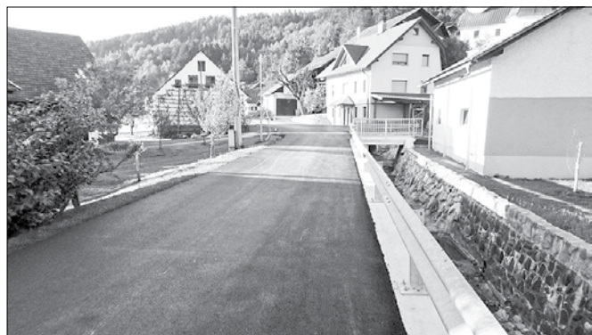
Središče Okonine z razširjeno in urejeno strugo potoka in novo asfaltno prevleko na vozišču (Fotodokumentacija Občine Ljubno)
