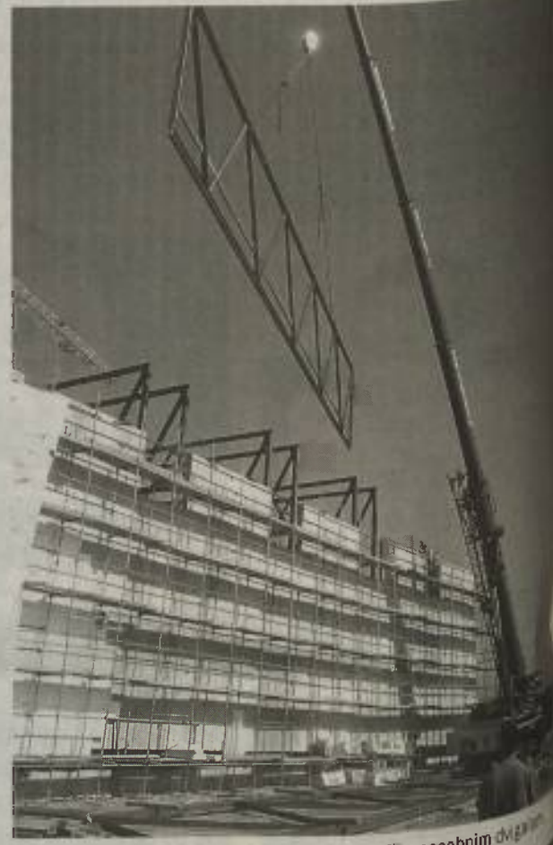
Jekleno konstrukcijo so na telovadnico namestili s posebnim dvigalom.
