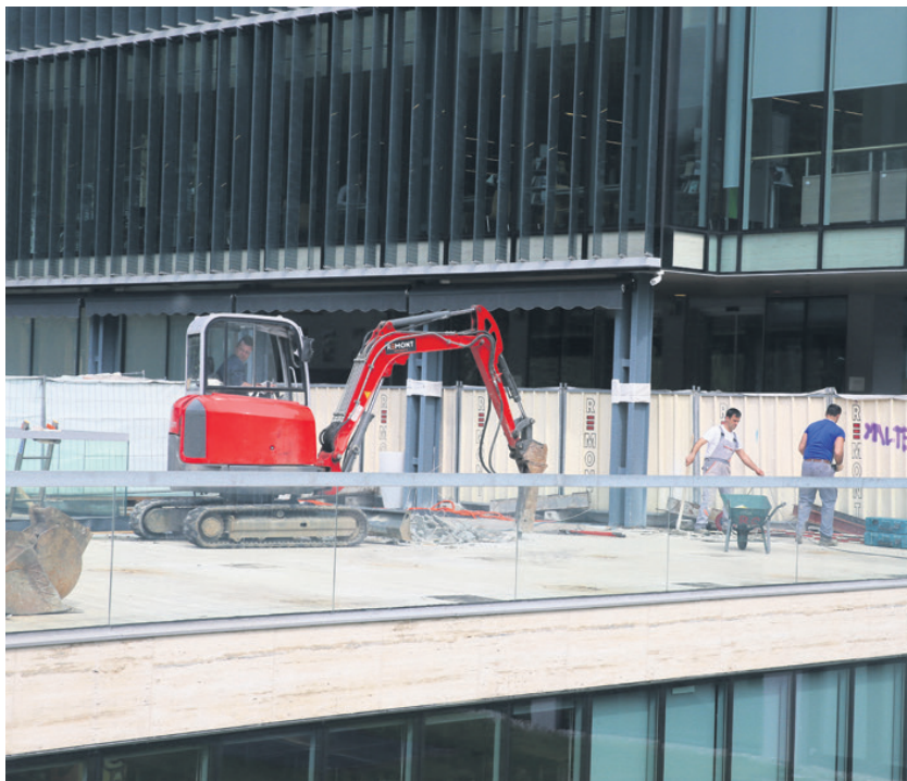
Obnova strehe otroškega oddelka pred knjižnico
