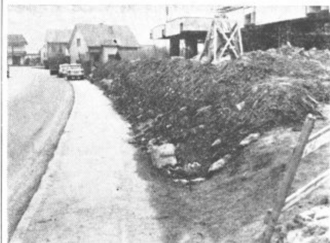
Ograje ni, prst pa so nasuli kar na pločnik. Kmalu po našem odhodu jo je buldožer že začel odstranjevati.
