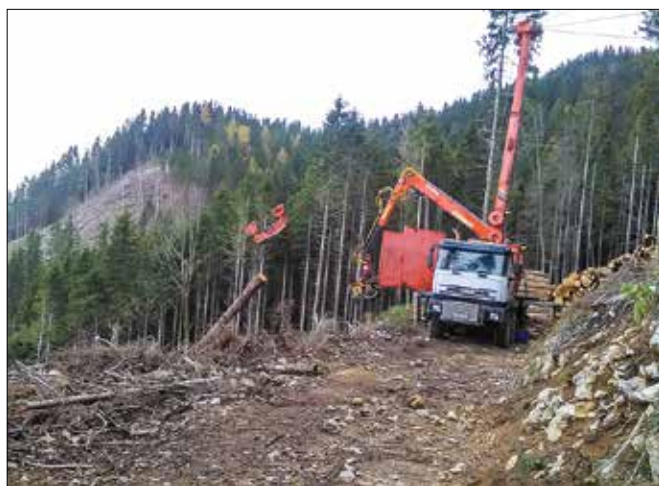
Izvajalci del so prejšnji teden začeli s sečnjo, žičnim spravilom in odvozom lesa na Golteh. (Foto: Tomaž Gerl)
