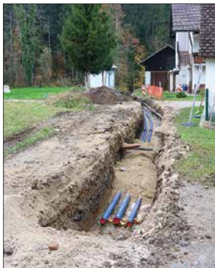
V Pustem Polju bo zaradi obnove vodovoda občasna popolna zapore odsekov ceste skozi naselje. (Foto: Marija Šukalo)
