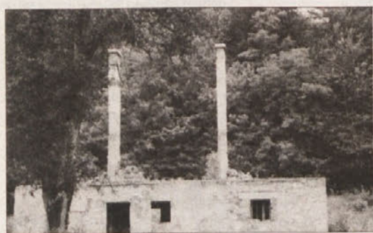
TEŽKO ČAKAJO NA DOM NA FRATI - V zadnjih poletnih dnevih je dom na Frati že precej v drugačnem stanju, kot je bil pred časom, ko ga je uničil požar, kar je dobro razvidno tudi iz priloženih fotografij. Lastnik Ludvik Legan je v obnovi v zadnjem letu vložil že kar lep kup denarja, med drugim pa je ohranil nekaj starih zidov in spominsko ploščo, gostje pa si bodo na fasadi lahko ogledali podobo nekdanjega doma na Frati. Obiskovalci vedno znova sprašujejo, kdaj bo dom odprt. Lastnik upa, da se bo to zgodilo še pred novim letom, ko naj bi začel obratovati spodnji, gostinski del. Zgoraj namerava kmalu zatem urediti še sobe in skupna ležišča. Upa, da z obiskom ne bo težav, saj povpraševanja že zdaj ne manjka. Ob sobotah in nedeljah je obiskovalcev toliko, da se Ludvik pred vprašujočimi pogledi raje umakne, saj jim ne more še nič ponuditi. (Foto: J. D., B. D. G.)
