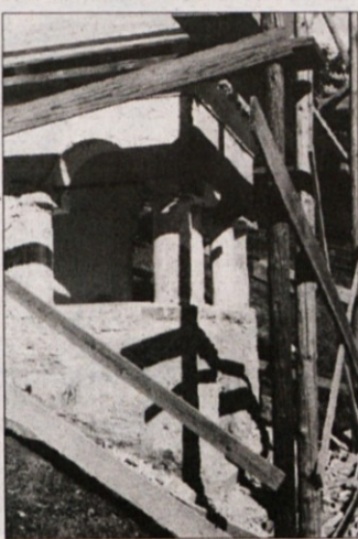
Obnova kapelice v Retjah.
