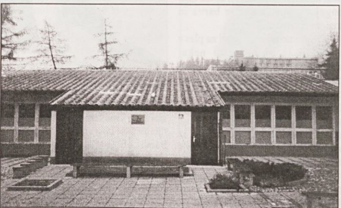
slika 3. Del glasbene šole v nekdanjem vrtcu
