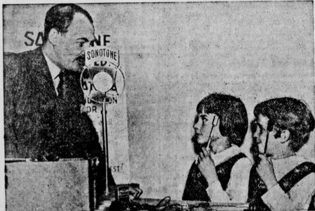
Slušalko za gluhe kažejo na londonski medicinski razstavi. Nekdo govori v mikrofoni, glasovni valovi pretresajo palčke, katere ima gluhec pritrjene na glavi. Stresljaje teh palčic občutijo tudi možgani, vsled česar gluhec lahko sliši v mikrofoni izgovorejeno besedo
