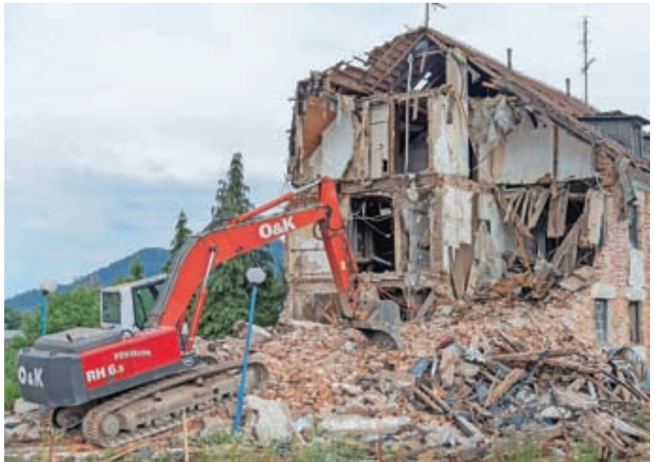
Štiri leta bo, odkar so podrli nekdanji Sokolski dom v Medvodah (rušitev je potekala poleti 2018, na sliki). Investitor načrtuje gradnjo stanovanjsko-poslovnega kompleksa.
