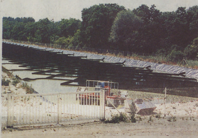
Račja leča je stabilizirana v mreži, da je čim manj gibanja - iz te lagune bo šla voda v Muro. Dvakrat letno bodo želi račjo lečo s posebnim kombajnom.
