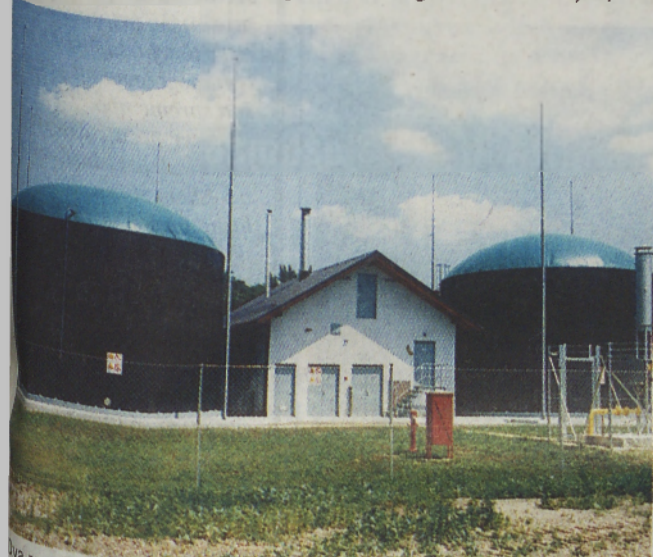
Va reaktorja sta namenjena proizvodnji bioplina, ki se bo uporabljal za proizvodnjo električne in toplotne energije za potrebe delovanja čistilne naprave. Človečen plin bo zgorel v »plamenici«.
