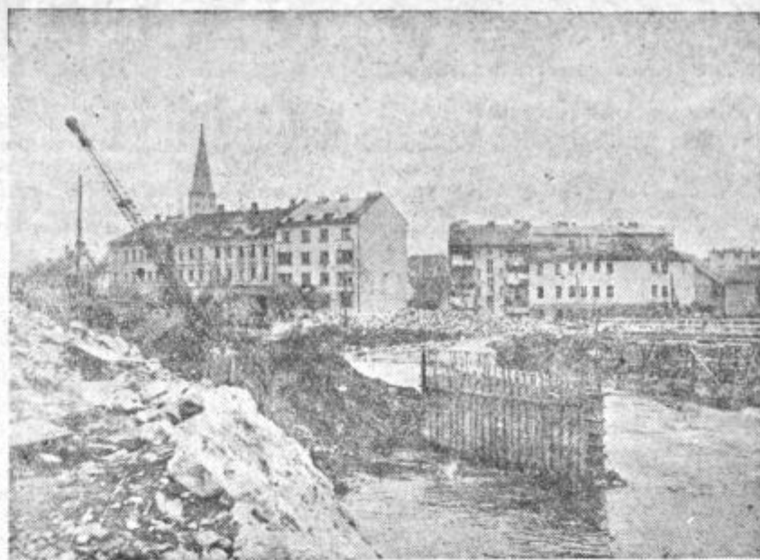
Med ostalimi deli že betonirajo dva opornika za novi železobetonski cestni most čez Savinjo
