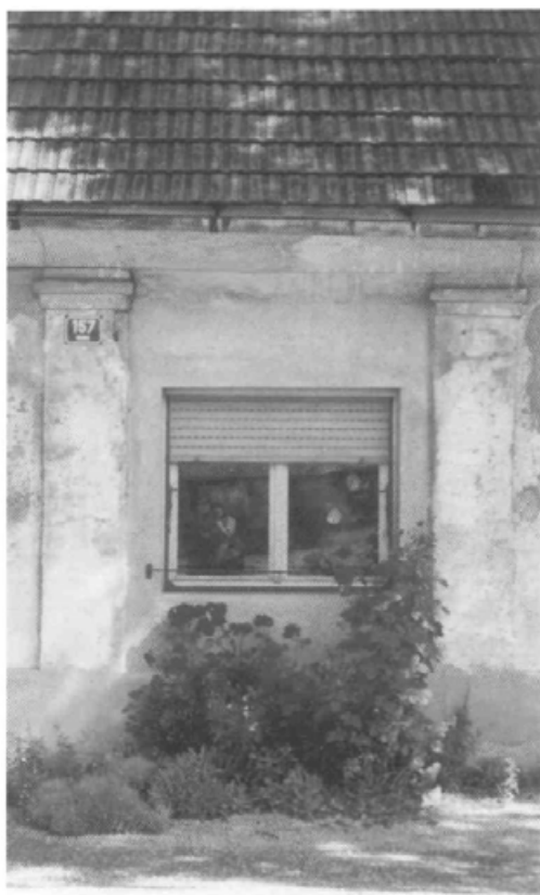
178. Nekdanji glavni vhod v hišo so zazidali in vanj vgradili okno.
