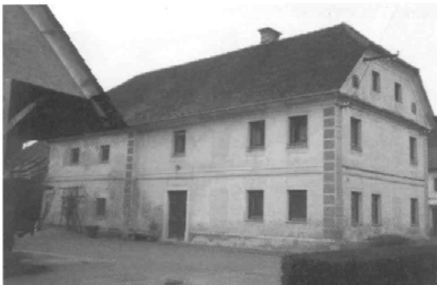
209. Dvoriščna stran Hladnikove hiše.
