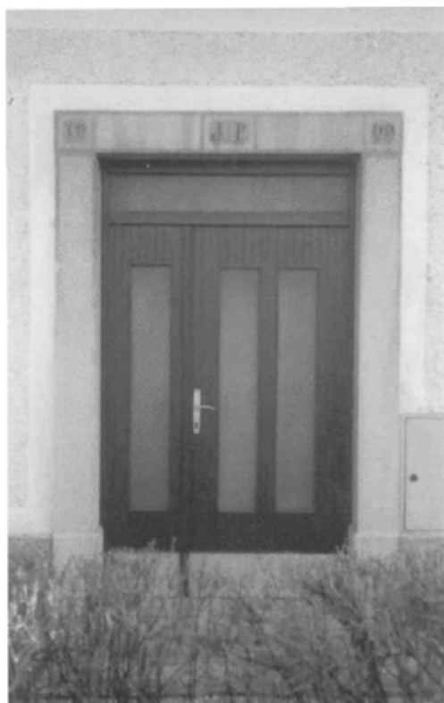
242. Vhod v hišo, ki jo je ob današnji Janezovi cesti v Janezovi vasi zgradil Janez Prelec.
