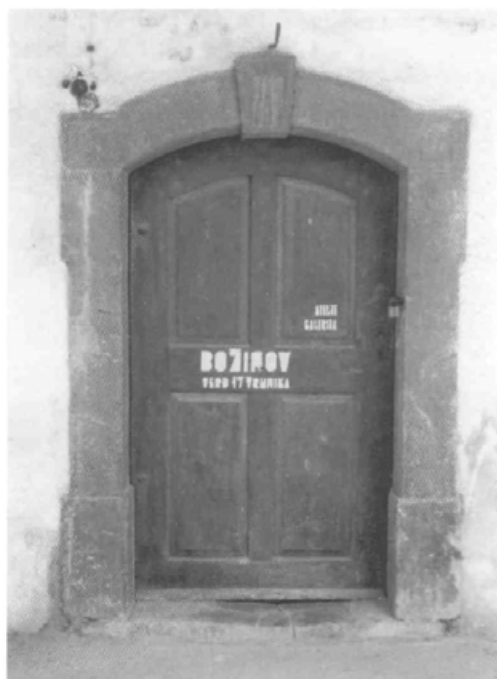
199. Vhodna vrata v hišo Verd 17, imenovano Unkovše.
