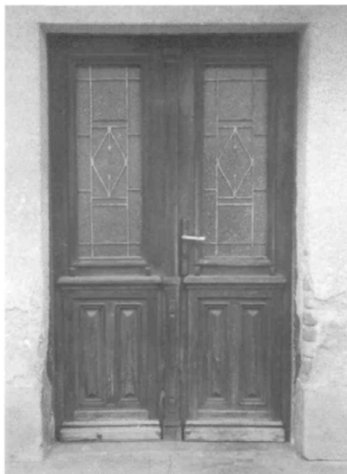
214. Vratnice nekdanjega glavnega vhoda s ceste, zapirajo od leta 1941 dalje dvoriščni vhod Furlanove hiše.
