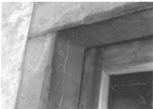
266. Portal Maroltove hiše ni datiran. Verjetno je nastal v drugi polovici 19. stoletja. Izdelan je iz črnega apnenca. Notranji robovi preklade in podbojev so porezani na ajdovo zrno, podobno kot leta 1877(?) 184 ) okvirji Kotnikovih vrat.
