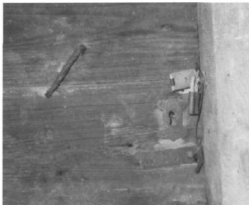
316. Primež iz spiralno zvitega železa in ključavnica na kletnih vratih v "Mik'lčevo" kaščo.
