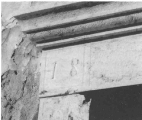
265. Portal Petkovškove rojstne hiše je izdelan leta 18 78 iz rožnatega lesnobrdskega apnenca, ki je očitno med manj trdnimi kameninami. Barva je že precej obledela, zglačene površine so brez leska, v posameznih portalnih delih pa je tudi precej razpok. Razen Piškovega portala (Verd 153) ima ta nad preklado edini oblikovan še profiliran napušč.
