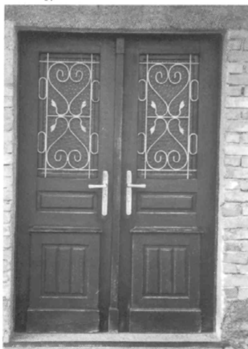
174. Vratnice glavnega vhoda zapirajo danes dvoriščni – edini vhod v Turšičevo hišo.
