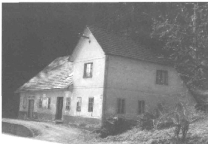
143. "Pritlično hišo, spojeno s hlevom" je zgradil leta 1904 Franc Merlak.
