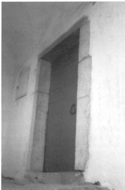
249. Vrata v zgornji del "Mik'lčeve" kašče. Kamniti okvir je bil vgrajen med samo gradnjo, saj je zunanji rob kamnov neobdelan.
