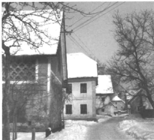
119. Nekdanji južni konec strnjene vasi; na levi strani "Štefinova" domačija s hlevom in stanovanjsko stavbo, potem "Jernejovcova" hiša, v sredini zadaj nekdanja Varškova hiša, na desni strani "Ketetovše", danes Gostiša. Foto: I. Sedej, leta 1963. Vir: LRZVNKD, int. št. 95.
