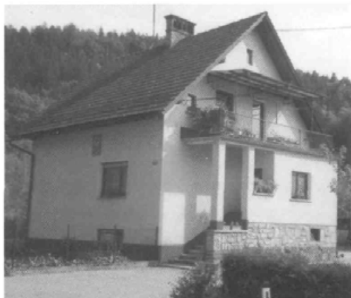
123. Žakljeva hiša, grajena leta 1953, je ena redkih povojnih stanovanjskih stavb z dvema vhodom, sprednjim in zadnjim. Samostojna garaža je bila grajena leta 1971.
