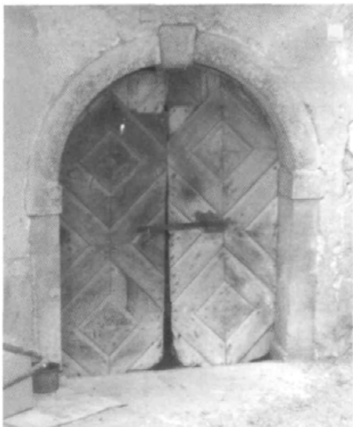
268. Zamaknjen vhod v Hodnikovo hišo, na vrhniški Stari cesti, s tipičnim notranjskim šesterostranim tlorisom 182 . Portal je zaključen s polkrožnim segmentnim lokom, sredi katerega je sklepnik z rdeče napisanimi začetnicami I. H.. Podboja sta izdelana iz črnega apnenca, deli loka iz sivega.
