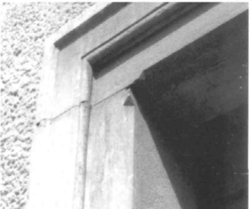
267. Notranji rob podbojev in preklade glavnih vrat Kotnik Lenarčičeve hiše je prav tako posnet na ajdovo zrno.
