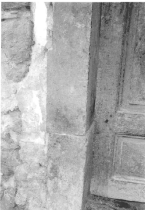
261. Baza dvoriščnega vhoda Žitkove hiše št. 13 je enostavna kamnita prizma brez posebnih likovnih poudarkov. Baze večine portalov so sicer posebej oblikovan element, ponavadi malo širše od podboja. Nekatere imajo tudi zglajene ali profilirane robove. Največkrat so zaključene v višini hišnega cokla.
