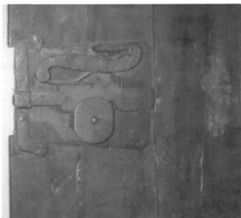
315. Vratna ključavnica na notranji strani vrat v nadstropje "Mik'lčeve" kašče.
