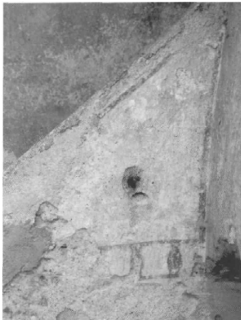
294. Na zidani ograji stopnišča, ki vodi v nadstropje Maroltove kašče, je precej poškodovan, z opečnato rdečo barvo naslikan vzorec, s katerim so morda poskušali posnemati motiv balustrov. S črtami enake barve so v notranjosti kašče poudarjeni robovi obokanega stropa. (Fotografija je nastala leta 1995 – danes je vzorec v še slabšem stanju).
