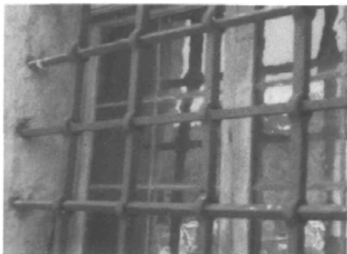
308. Okna cerkve sv. Antona so zamrežena s palicami, sestavljenimi enako kot preprosti križi manjših oken.
