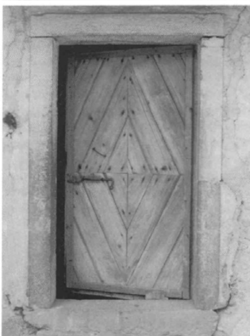
247 in 248. Vhod v zgornji in spodnji del Meletove kašče na Mirkah, ki je bila po pripovedovanju postavljena konec 17. ali v začetku 18. stoletja. Zgornji portal ima ravno preklado, polkrožni portalni lok spodnjih vrat je iz enega samega kosa. Deščice zgornjega vratnega krila so spojene v vzorec romba, spodnje enostavno vodoravno.
