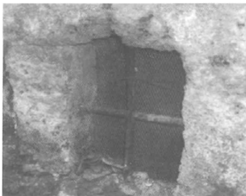
309. Kletno okno Maroltove kašče je zaščiteno s preprostim križem; pokončna palica ima na sredini oblikovano zanko, skozi katero je vstavljena vodoravna palica.
