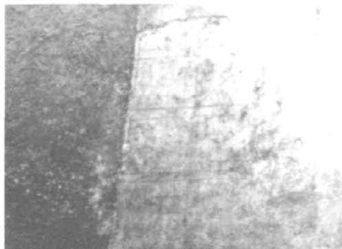
293. Na neosončeni severni strani Žitkove hiše št. 13 je na robu prizidka ostal z rdečo barvo narisani osnutek šivanega roba. Jasno so vidne v mrežo pravokotnikov vrisane diagonale, s pomočjo katerih so razdelili vzorec na enakomerne manjše dele.
