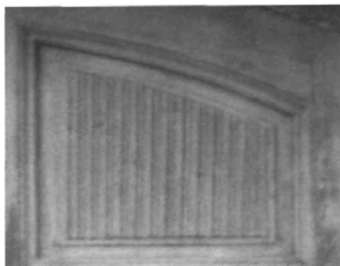
341.: Zgornja tabla dvoriščnih vratnic Stražišarjeve hiše sledi segmentnemu loku portalnega okvirja. Med navpičnimi žlebički so poudarjena rebra.
