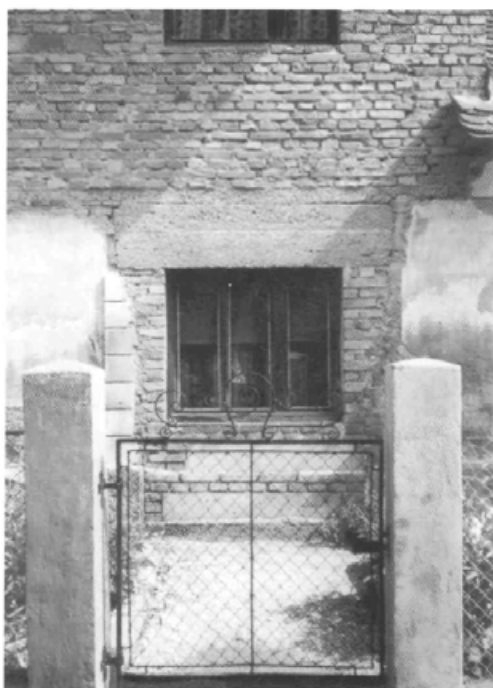
175. Zazidan glavni vhod Turšičeve hiše, Verd 163.
