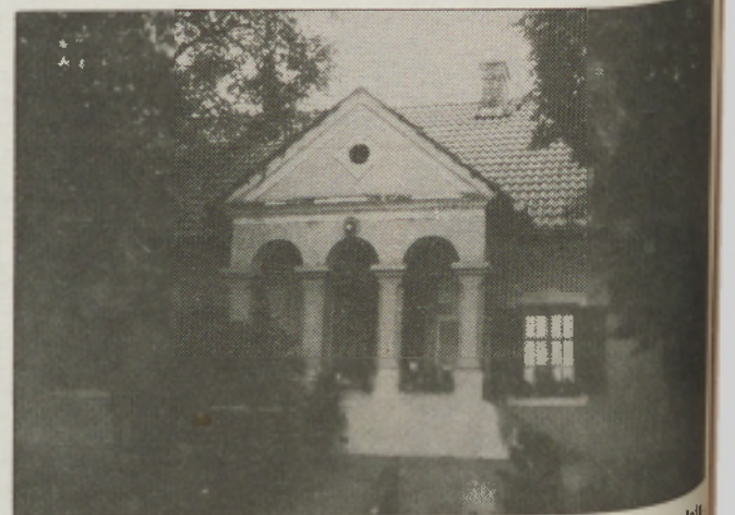
Prapotnikovi iz Pavlovci živijo v mogočni hiši, zgrajeni 1911. leta so jo obnovili.
