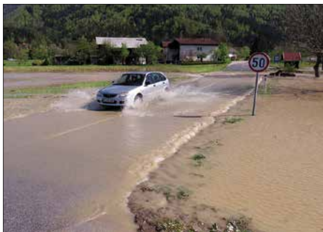
Precej škode je na cesti v Potoku. (Foto: Igor Solar)
