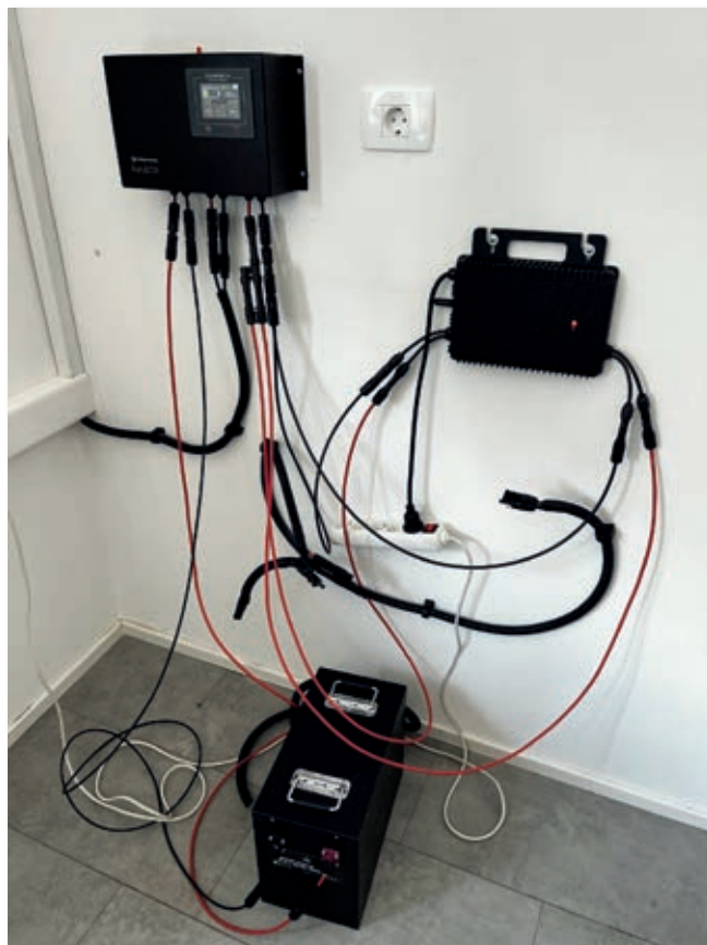
△ Na fotografiji je celoten komplet elektronike, ki jo potrebujete za kombinacijo balkonske elektrarne in baterije. Levo zgoraj je polnilec, desno je razsmernik in spodaj baterija.
