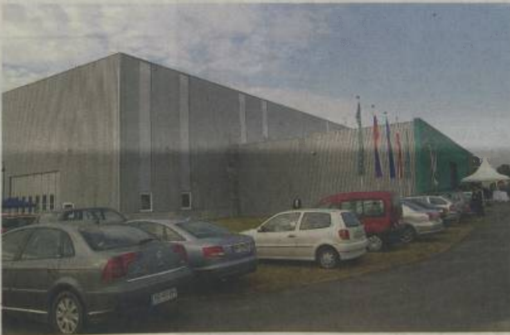
V novi tovarni podjetja Komptech v Ljutomeru bodo izdelovali stroje za mehansko in biološko obdelavo odpadkov, ki bodo pomembno prispevali k čistejšemu okolju. Že letos bo v njej delalo petdeset delavcev. Foto: M. H.
