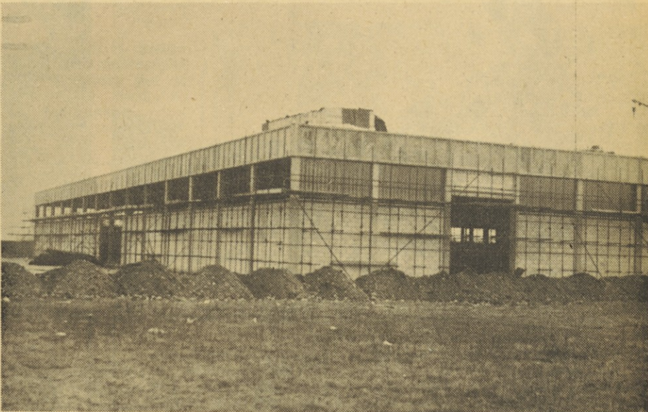
Novo glavno skladišče TOZD IMP PMI Maribor, ki obsega 6.300 m 2 površine, so začeli graditi septembra lani, odprli pa naj bi ga konec letošnjega aprila
