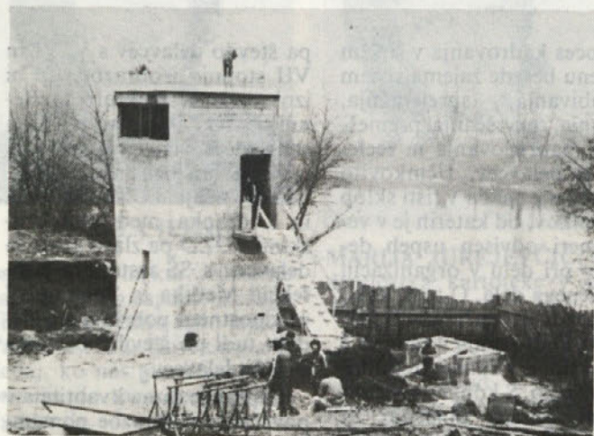
Takole podoba pa ima črpališče tehnološke vode za Beti tik pred zaključkom del.
