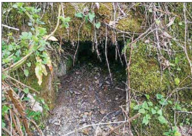
Unikatni primer več kot 60 let starega kamnitega prepusta nad katerim se odvija težki tovorni promet
