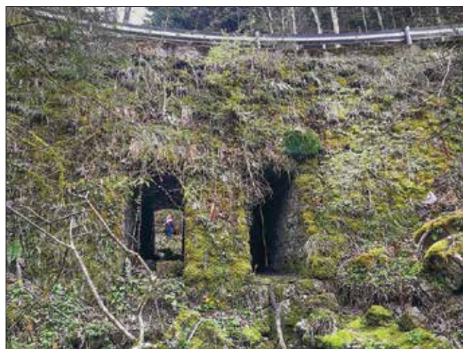
Slika mostu danes po več kot 60-ih letih z ograjo iz današnjih časov
