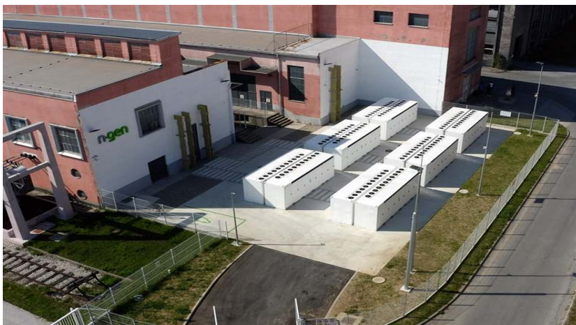
Slika 7: Baterijski hranilnik priključne moči 15 MW in kapacitete 30 MWh
