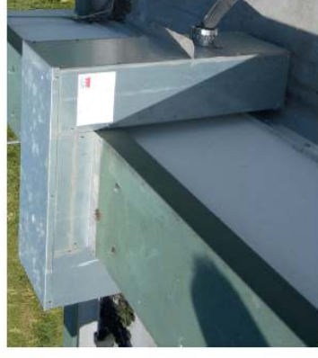
Bild 4: Verlegung von Leitungen über eine Brandwand mittels Brandschutzkanal (Quelle VGH)
