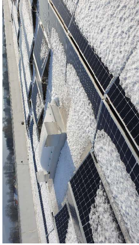
Bild 3: nicht erlaubte Verlegung von Leitungen über eine Brandwand (Quelle VGH)
