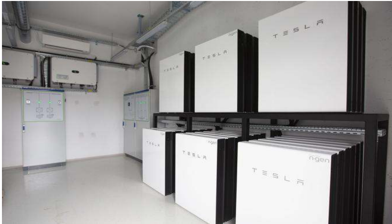
Slika 2: Hranilnik je mogoče namestiti na tla ali steno
