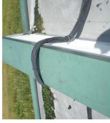
Bild 3: nicht erlaubte Verlegung von Leitungen über eine Brandwand (Quelle VGH)
