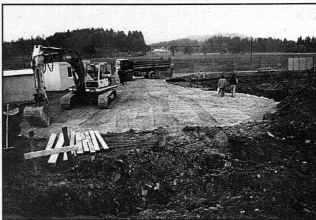
Gradnja gornjegrajske čistilne naprave pospešeno napreduje (foto: Ciril Sem)
