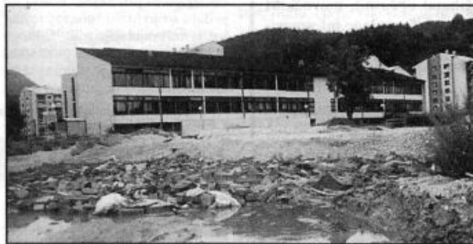
Pri šoli Šalek v Velenju so se lotili ureditve športnega igrišča. Malo upanja je, pravi ravnatelj, da bi dela letos tudi končali.
