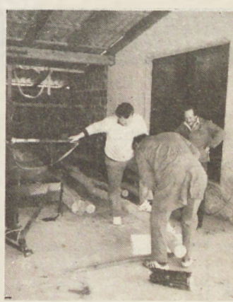
Najprej je bilo treba pripraviti les za novo škarišče, ki nosi nosilno vrv broda. Za ta dela v Krogu ni bilo težko najti pravih moštrov.
