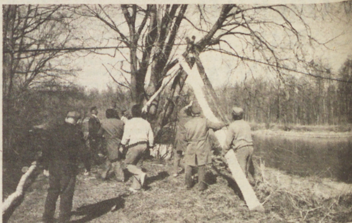
Najtežje je bilo postaviti novo škarišče na levem in desnem bregu Mure in potem prek njiju napeti jekleno vrv, ki tehta nekaj ton. Ampak tudi to so večje opravili. Zdej je brod spet usposobljen za varno vožnjo čez Muro.
