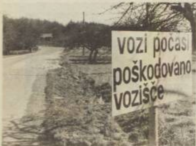
Od Sebebores pa vse do Fokovec je kar nekaj takih opozorilnih napisov. Poškodovano vozišče! Čestitke je na nekaterih delih zelo poškodovano, vozniški pa morajo večkrat krepko pritisniti na zavorno, ko naletijo na makadamske površine. Le kdaj bodo spet prekriti z asfaltom?
