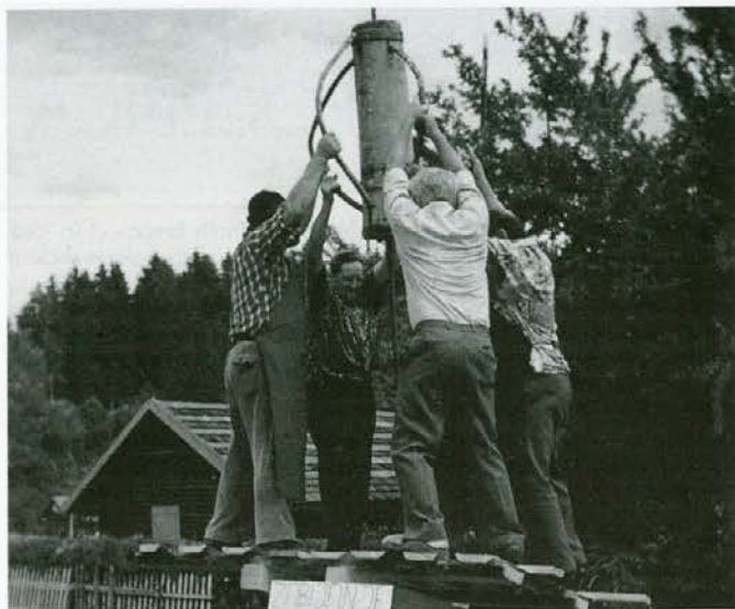
Zabijanje kolov - pilotov z "bidrom"
