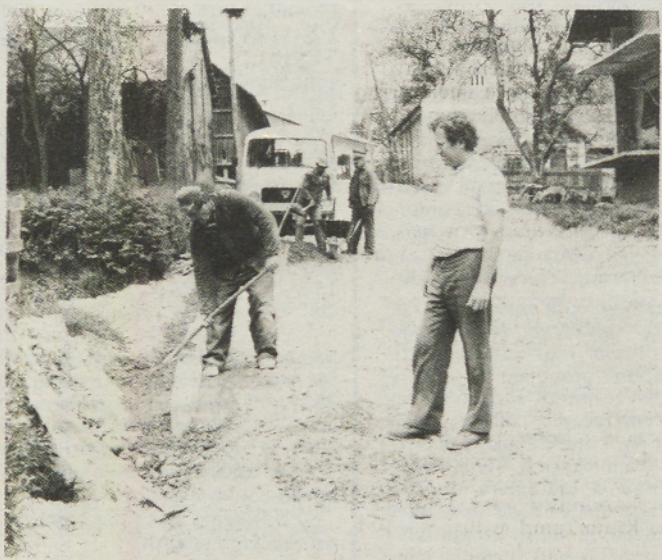
Ko so gradbeni stroji brneli mimo domačije Štefana Očka in ko so tam delavci podjetja Pom-Grad opravljali zemeljska dela, je bil Štefan ves vznemirjen. Končno bo tudi skozi Ivanjševce vodila asfaltna cesta. (Posnetek: JOG)
