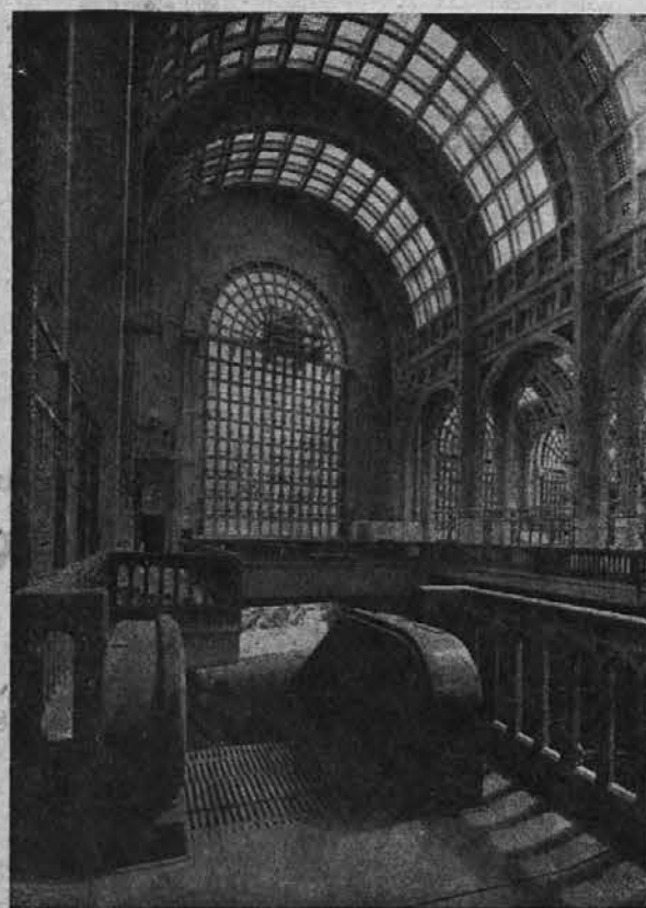
Prvo nadstropje: Pogled preko eskalatorja na en del stranskih obokov
