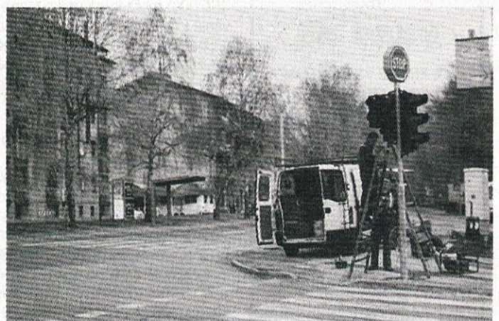
Montaža semaforjev pri Svetilniku
