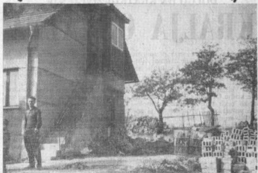
Ob hiši na desni je stal porušen prizidek, ali »nova« črna gradnja ob »stari« črni gradnji... V prihodnje bo še nekaj takih energičnih ukrepov, toda o tem v prihodnji številki. Pri vsej zadevi je žalostno le to, da so nekateri ljudje prišli ob skromne stanovanjske možnosti in celo ob sredstva — vse zaradi špekulacij in neupoštevanja predpisov
