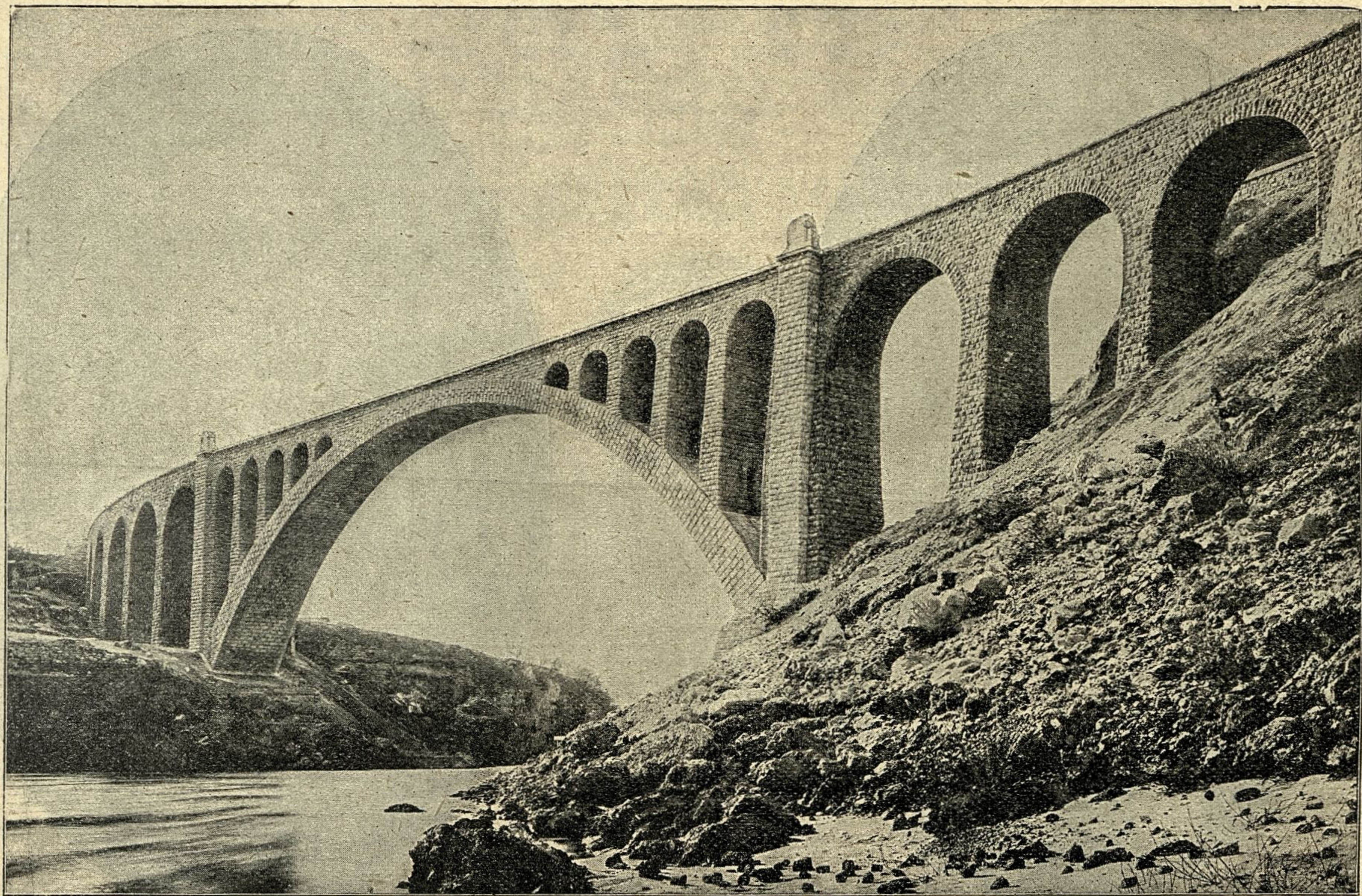
Die Wocheiner Bahn: Ssonzobrücke bei Salcano, die weitgespannteste steinerne Eisenbahnbrücke der Welt.
