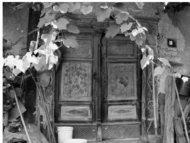
Detajlno izdelan vhod zidanice, Drožanje 4. Foto: Tina Lorbek, Sevnica, 16. 7. 2009
