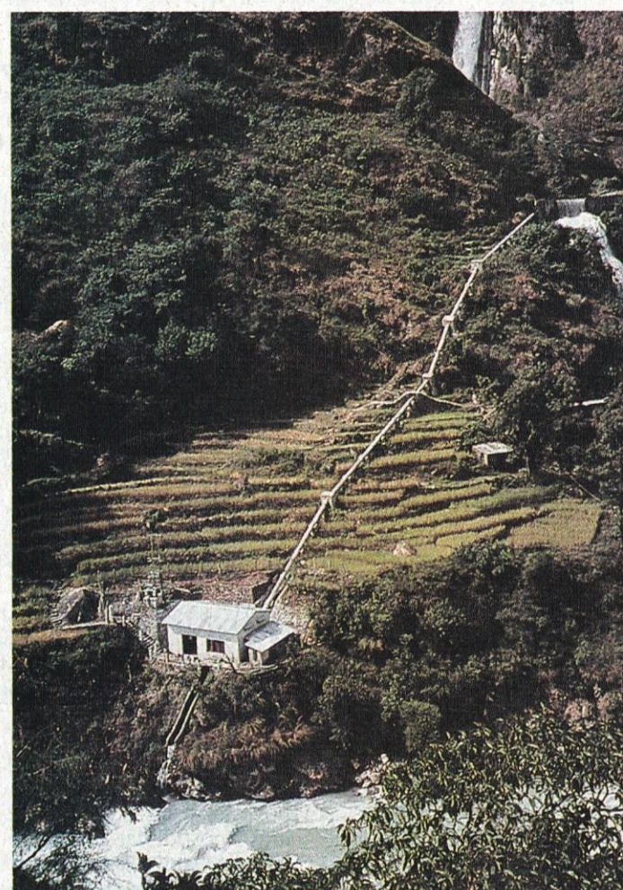
Ena od malih hidroelektrarn izkorišča energijo enega od mnogih slapov, ki z okoliških pobočij padajo v Masiandi
