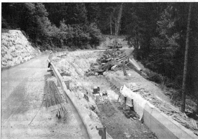
Sanacijska dela na cesti proti Pavličevemu sedlu (foto: Savinjan)
