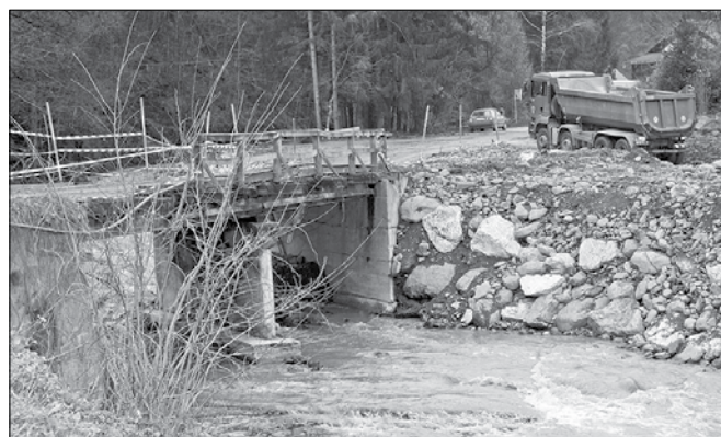
Most je prevozen za lažji promet. (Foto: Marija Lebar)
