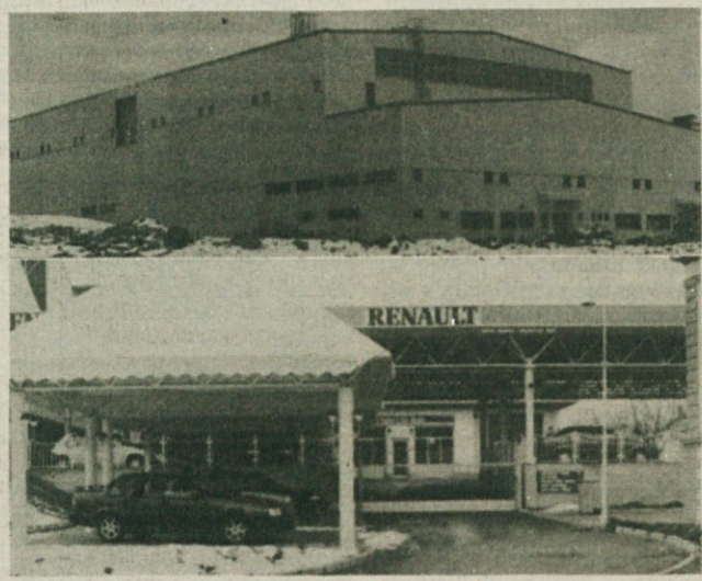
POCENI ČRNE GRADNJE — Povprečno je kazen za vsako od teh dveh Revozovih črnih gradenj gradbenice veljala po 1.000 tolarjev. Skupna tlorisna površina črnih gradenj znaša 8.077 kvadratnih metrov, se pravi, da je kazen za 1 m² tlorisne površine črne gradnje 0,2476166 tolarja. (Foto: A. B.)
