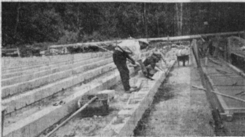
Gradnja pasovnih temeljev za umetno drsališče v celjskem mestnem parku
