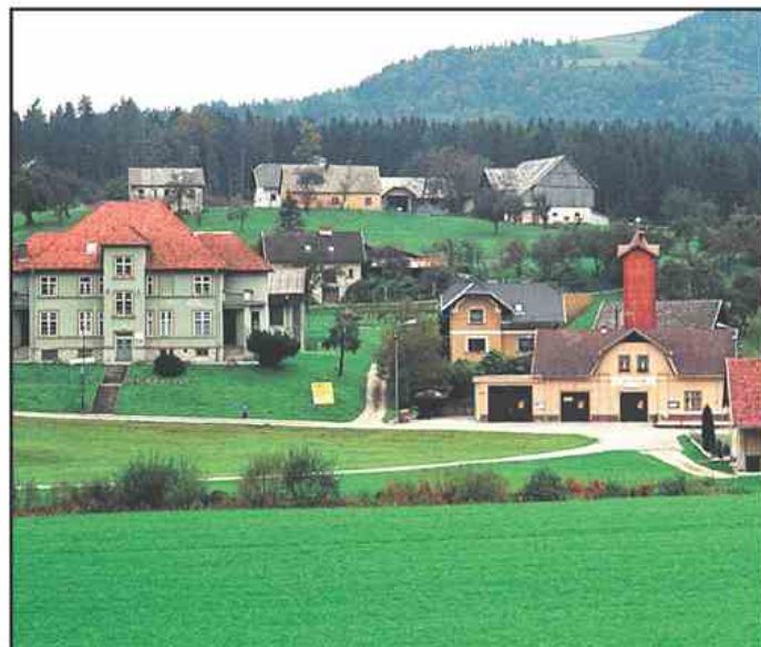
Nov dom krajanov in gasilski dom bodo zgradili v neposredni bližini obstoječega.
