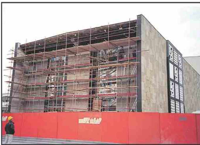
Med bolj zahtevne posege sodi prav zamenjava kamna na pročelju doma, ki bo končana še letos.
