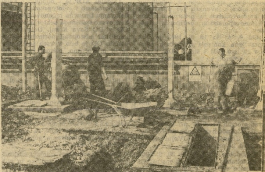
Delavci kranjskega Gradbinca so odkrili cevovode na črpališču...
