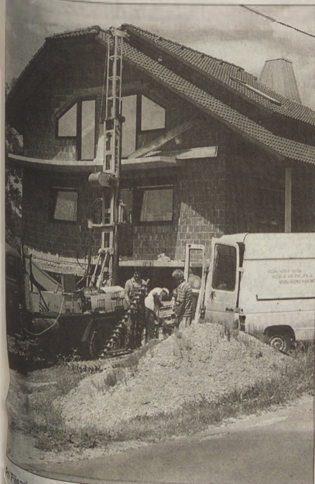
Flisarjevih na Pertoči je bilo treba zvrtati 19 metrov globoko, da so ujeli bogato plast vode podtalnice.
