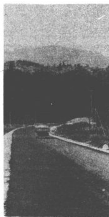
Tri kilometre dolg odsek ceste je že asfaltiran
