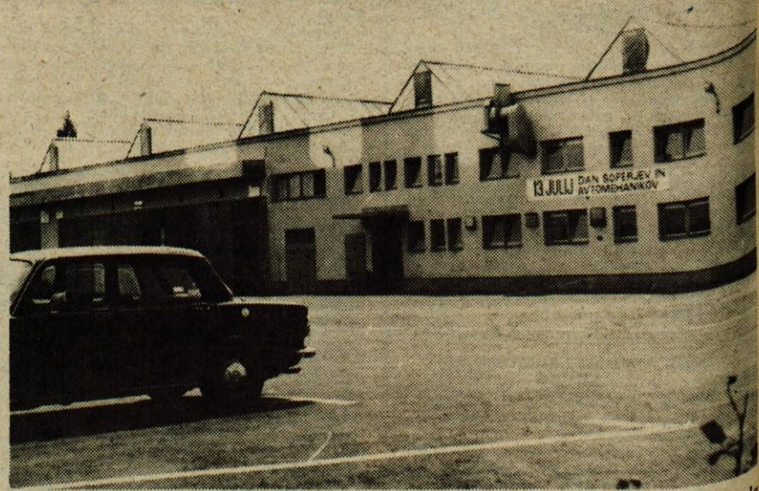
Škofja Loka – V soboto, 17. julija, so člani organizacije združenega dela Alpetour dosegli novo delovno zmago. Na Trati pri Škofji Loki so namreč svečano odprli nove prostore mehaničnih delavnic. Nove prostore so začeli graditi septembra lani, gradbena dela pa so veljala 15 milijonov din. Izvajalec del je bilo gradbeno podjetje Obnova iz Ljubljane. Za TOZD »mehanične delavnice« v organizaciji združenega dela Alpetour je to brez dvoma velika pridobitev. Obenem pa je to tudi velika pridobitev za škofjeloško in celotno gorenjsko področje. Zdaj so mehanske delavnice na Trati zaključene celota. Treba bo nakupiti le še opremo. Nakup le-te pa je predviden za prihodnje leto. Na svečanosti ob otvoritvi so nekaterim najzaslužnejšim in najprizadevnejšim članom Alpetourovega kolektiva ob dnevu soferjev in avtomekanikov, 13. juliju, podelili tudi posebna priznanja. (-jg) - Foto: J. Govekar
