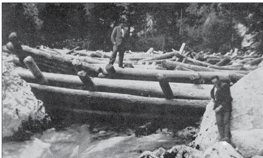
Zaláge, zadrževalniki hlodov na Savinji med svetovnima vojnama; zadaj plavljeni les (iz razprave Angelosa Baša iz leta 1977)
