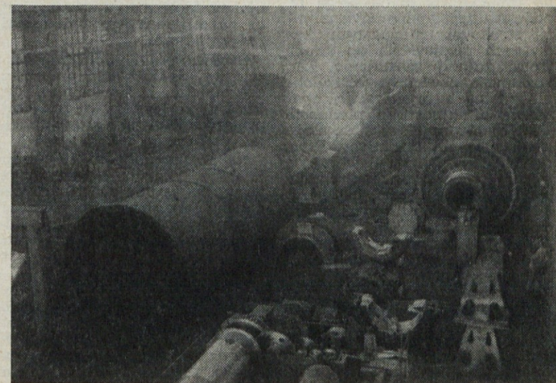
Cevni mlini za cementarno Beočin, Trbovlje in ŠAR v montaži
