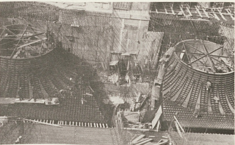
Na levi je dokončno izdelana sesalna cev prvega agregata, na desni pa sesalna cev za drugi agregat pred zaključkom
