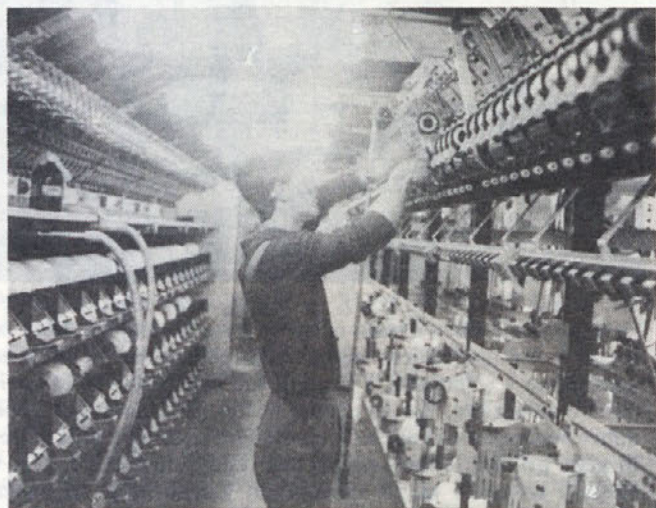
NOV STROJ — V tozdu Kodranka in volna so lani predvsem v delu kodranke veliko vložili v nove stroje. Zelo radi pa se pohvalijo prav s strojem za tekstoriranje finih prej za nogavice (na fotografiji), saj s temi prejami zalagajo tako rekoč celotno jugoslovansko tržišče.
