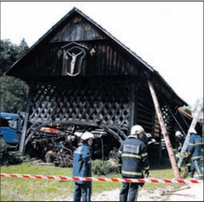
Skupil jo je tudi ozolec, ki ga je bilot rebap odpreti. Zaradi nevarnosti, da bi se kozolec porušil, so zaprli cesto Vinska Gora-Lokovina na odseku med gostiščem Hren in Avtoelektriko in vzdrževanjem vozil Hribaršek.
