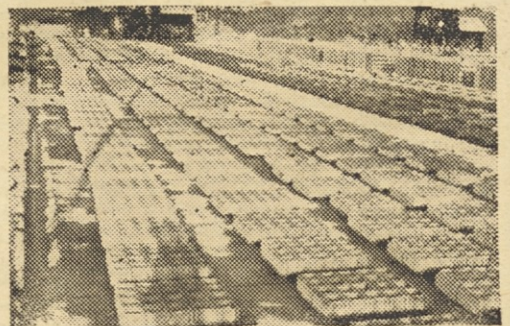
Pogled na ploščad, kjer dela stroj »Komet«. V ozadju je betonarna, ob strani pa skladišni prostor
