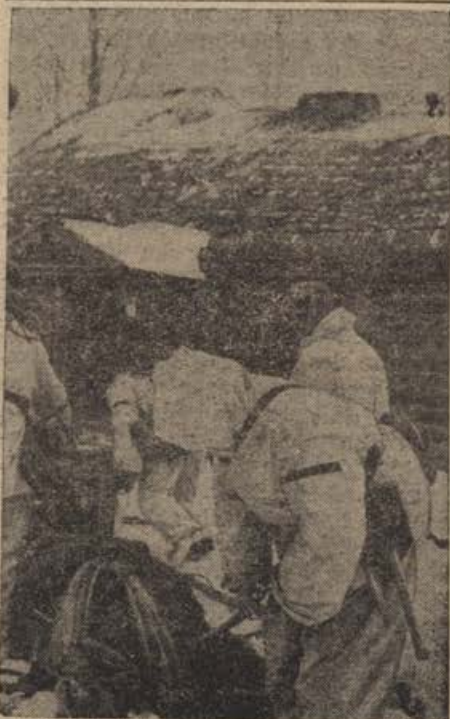
PK-Aufnahme: Kriegsber. Geller (Wb.) Sinnlose Zerstörungen kennzeichnen den Fluchtweg der Sowjets, die vor der Einnahme des Dorfes durch unsere Soldaten alle Häuser in Brand gesteckt und alles lebende Inventar erschossen haben.
