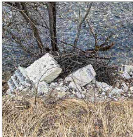
V porečju Savinje se je povečalo število mest z gradbenimi odpadki. (Foto: arhiv RD Ljubno ob Savinji)
